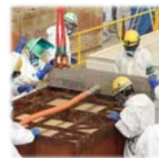
↑ 薬液による 脱硝触媒洗浄の様子
