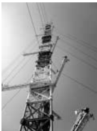
写真4 気象研究所のシンボル、高さ213mの気象観測用鉄塔（現在、取り壊し中…）。
